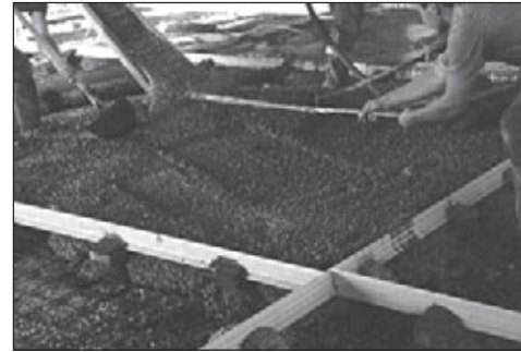
Coulage du béton
